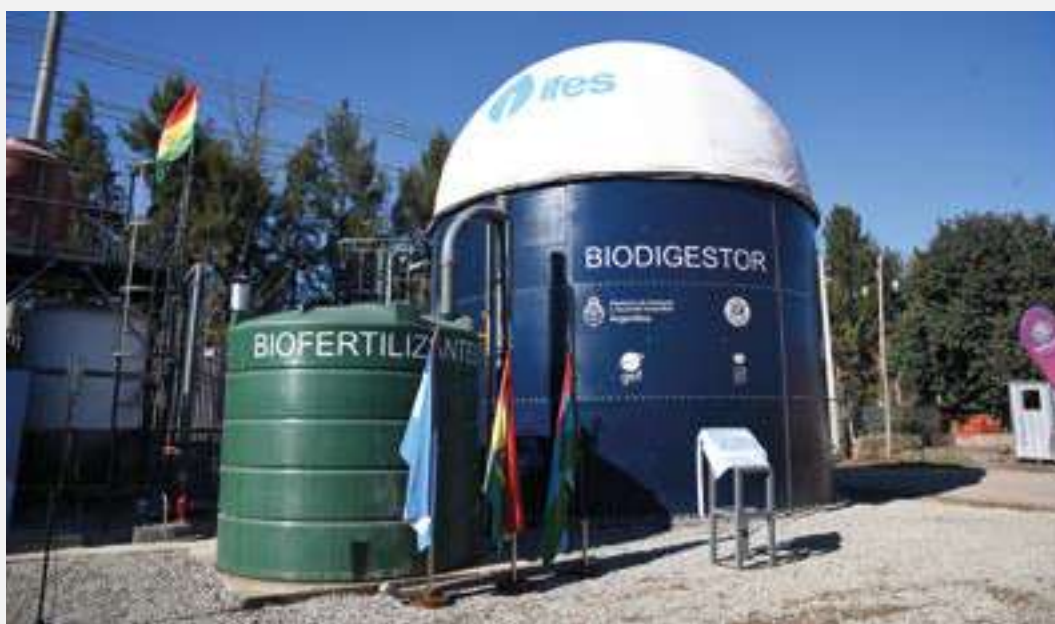
Figura 10. Instalación del biodigestor en el mercado concentrador de frutas y verduras de Escobar (derecha) y capacitación en la comunidad Wichi en Salta (abajo), (2020).
